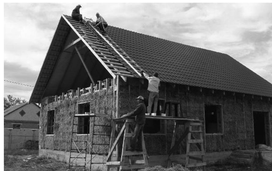
Рис. 3. Соломенные блоки в каркасе
